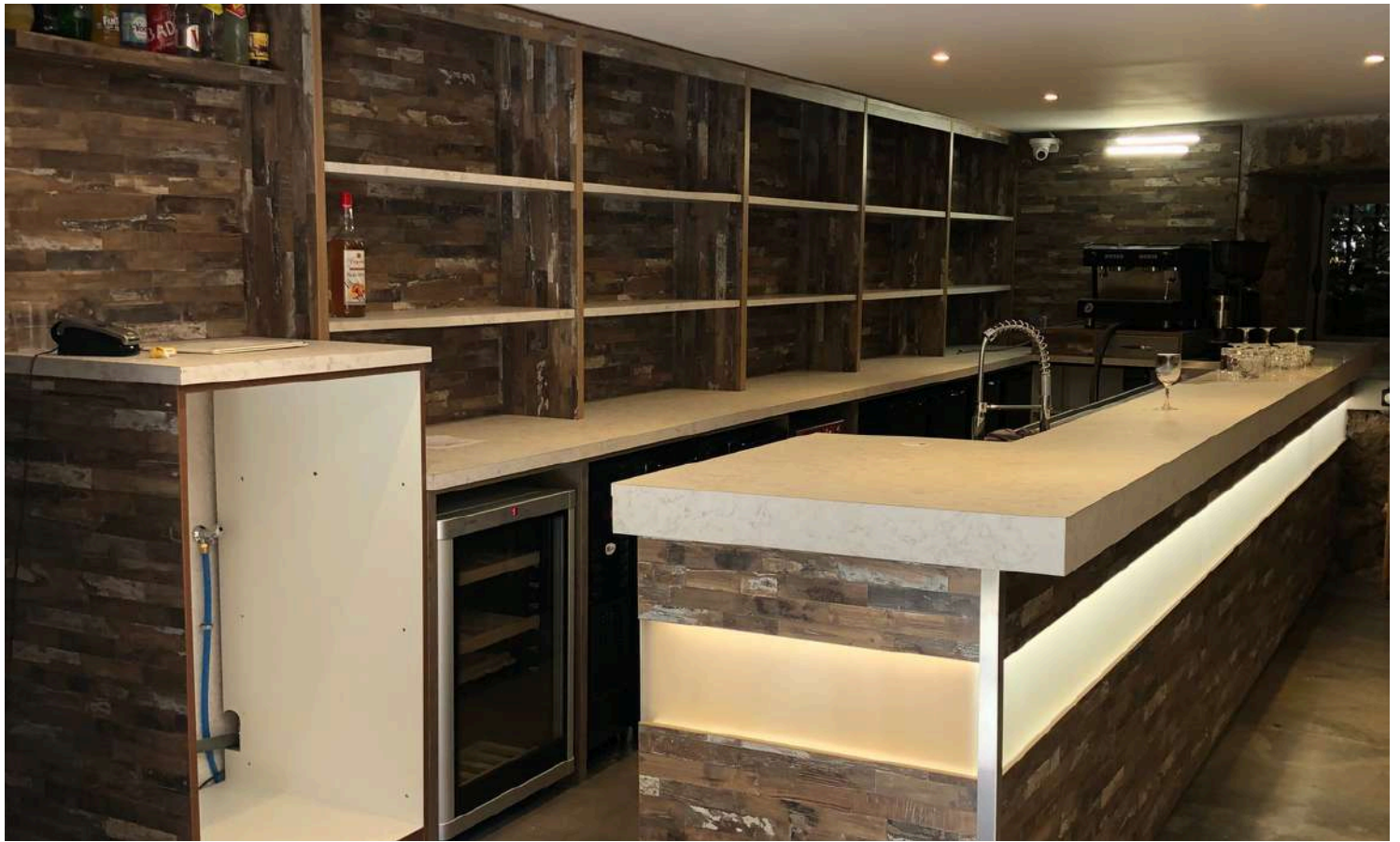
Fabrication d'un comptoir avec décoration façade en verre trempé dépoli et éclairage led. L'ensemble des meubles est réalisé en stratifié.
